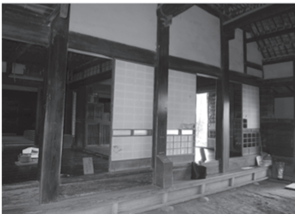
図12 旧三橋家住宅 土間・床上境
