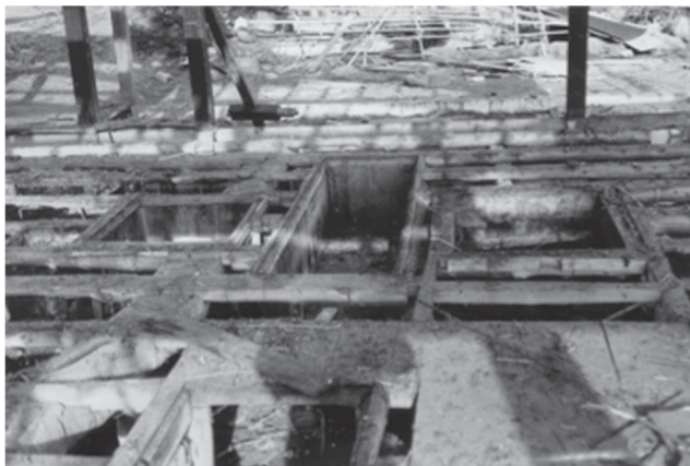
図 18 旧三橋家住宅 板の間床組(解体移築時)
